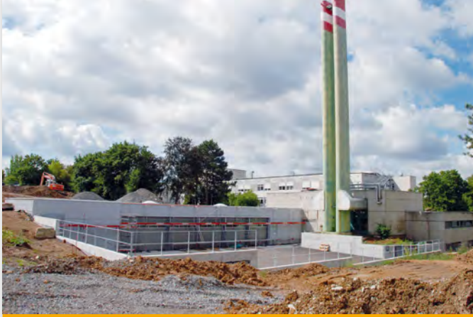
NEUES WIRTSCHAFTSGEBÄUDE IN TAUBERBISCHOFSHHEIM
